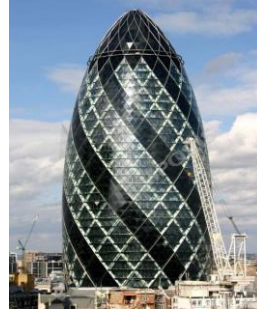
(شكل رقم 1) البرج المكتبي 30 St Mary Axe بلندن 2004 م وهيكله الإنشائي بالكامل من قطاعات الحديد الصلب المصدر مرجع [1].
