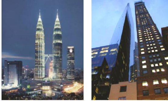
(شكل رقم 22) مبنى برجى بنروناس في كوالالمبور في ماليزيا المصدر مرجع [7].
