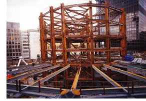
(شكل رقم 1) البرج المكتبي 30 St Mary Axe بلندن 2004 م وهيكله الإنشائي بالكامل من قطاعات الحديد الصلب المصدر مرجع [1].
