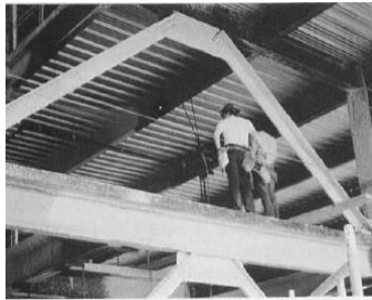
(شكل رقم 16) يوضح الشكالات المستخدمة في تدعيم الإطارات المصدر مرجع [2].
