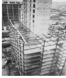
(شكل رقم 3) يوضح استخدام قلب خرساني وباقي الهيكل من الحديد المصدر مرجع [2]
