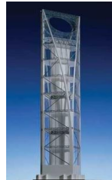
(شكل رقم 24) يوضح ايزومترى موضح عليه أماكن استخدام الجمالونات الرابطة Outrigger والأحزمة الجمالونية على المحيط الخارجي للمبنى العالي المصدر مرجع [2].
