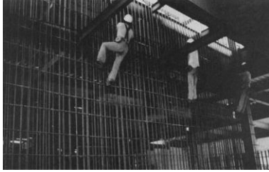
(شكل رقم 5) استخدام التسليح المزدوج للأعمدة والحوائط للحصول على الهيكل المركب المصدر مرجع [2]
