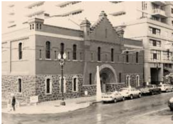
شكل 3. يوضح صورة للمبنى بعد الترميم (24)
