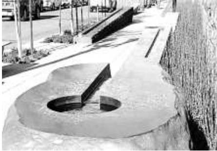
شكل 7. يوضح وحدات تجميع مياه الأمطار الخارجية (20)
