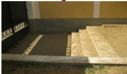
شكل رقم (23) المدخل الإدارى لمدرسة النور بالمنوفية المصدر : الباحثة
