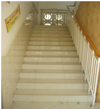
شكل رقم (46) السلم الداخلي بمدرسة مصر الحرة التجريبية للغات بالمنوفية المصدر : الباحثة
