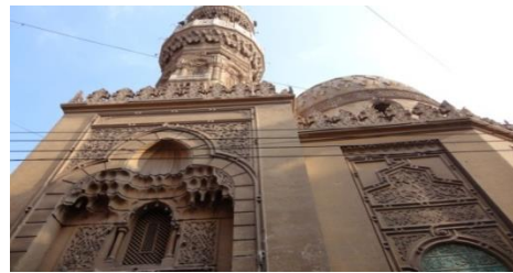
شكل ٩: الواجهة الشمالية الغربية الرئيسية لمسجد الشيخ مرزوق.
